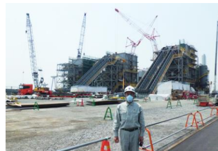
2012年5月 石巻市 「焼却プラント建設現場」視察
